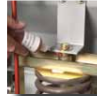
o. Main Closing Spring Guide Rod
